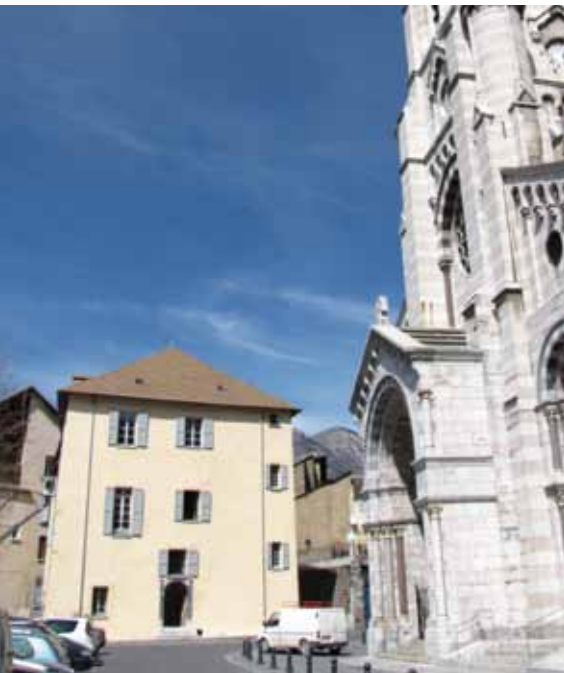
La maison paroissiale Saint Arnoux en cours de travaux, à Gap.
